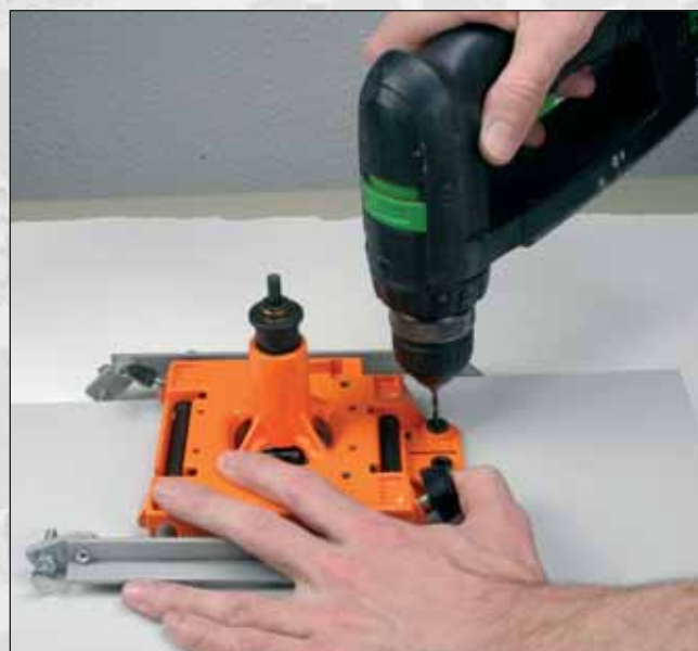
Photo 12 : perçage du montant
