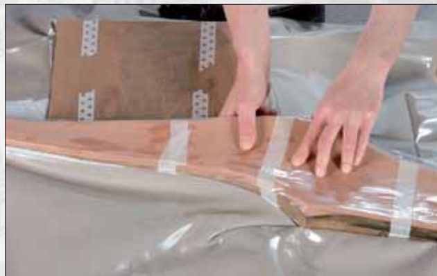
Une pression de la main aide à la mise en place de courbes serrées.
